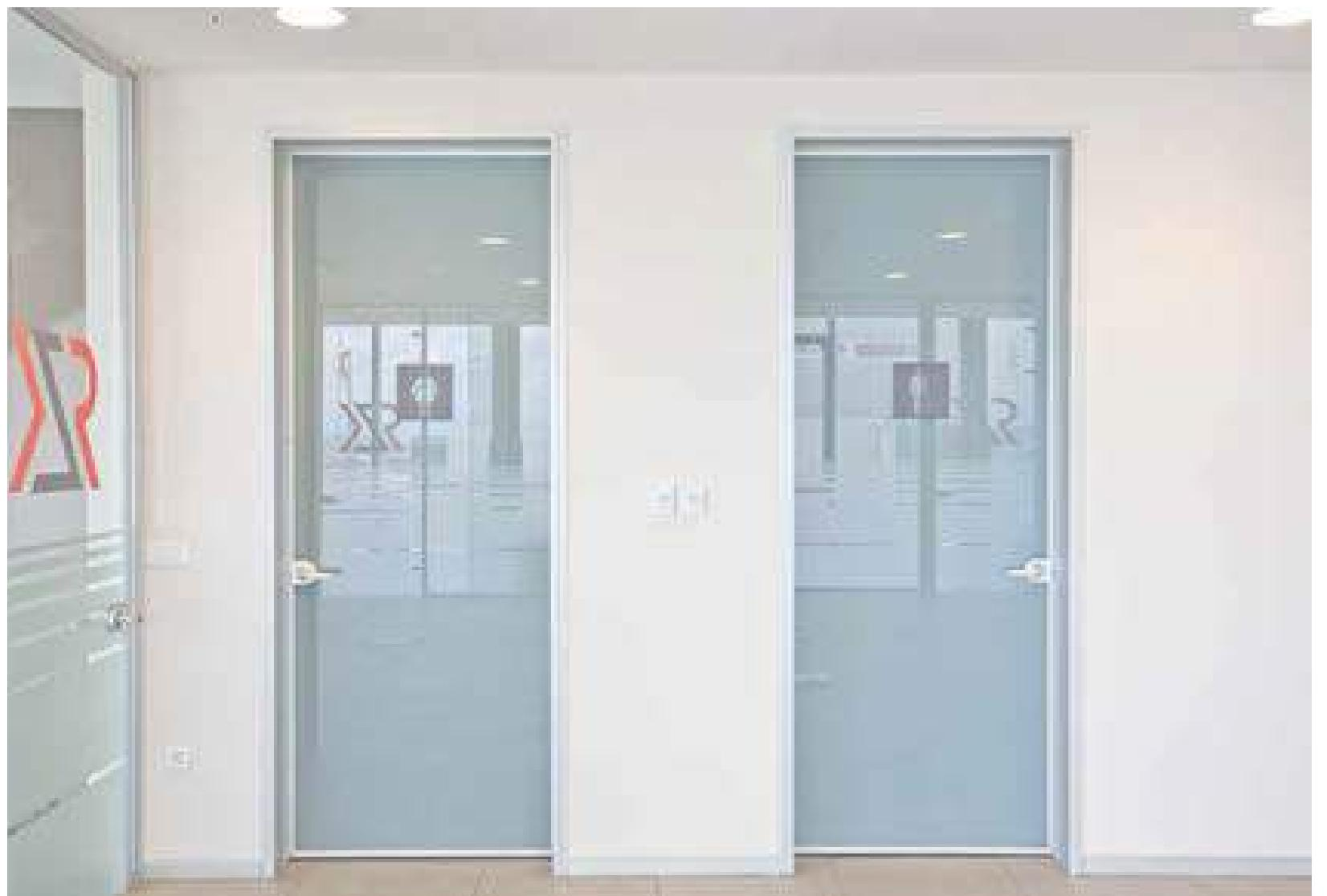
Teleskopik ayarlı alüminyum kasalı kapı sistemlerimiz ve zemin bağlantılı profilsiz cam kapı uygulamalarımız, çok geniş bir yelpazede geçiş çözümleri sunuyor.
