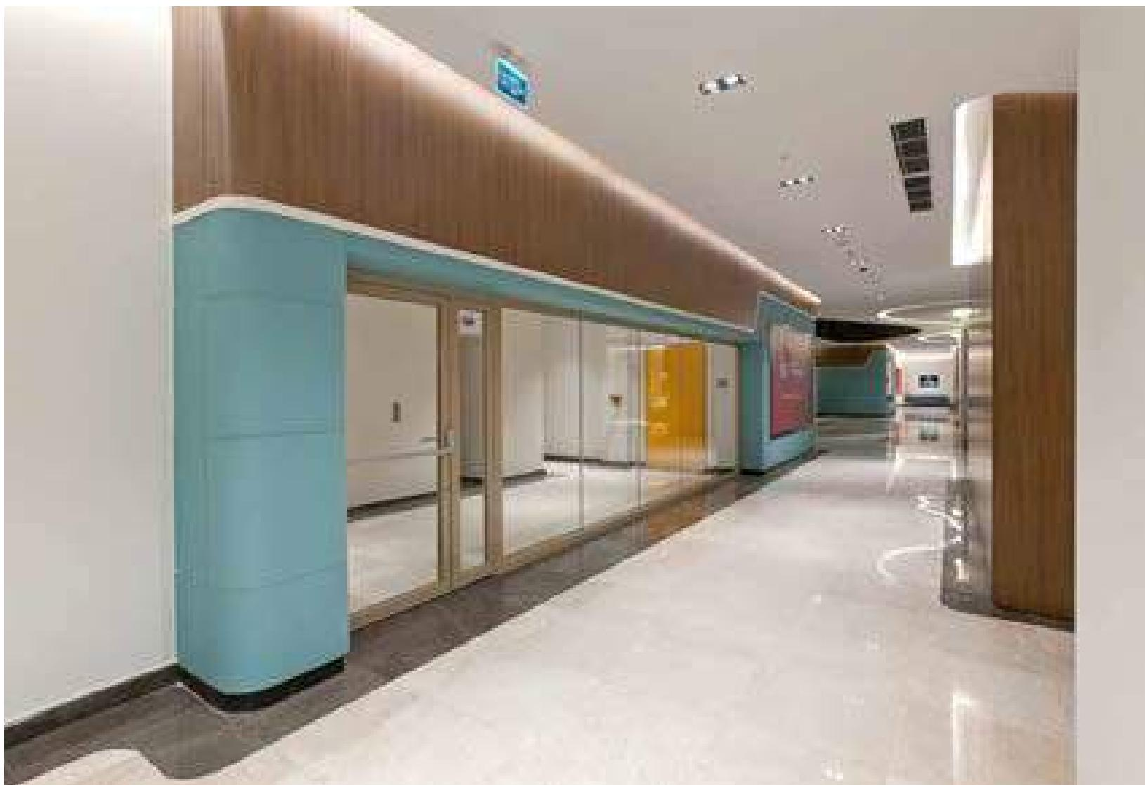
Yangın dayanım sertifikasına sahip profil, cam ve aksesuarlar kullanılarak oluşturulan yanğına dayanıklı camlı bölme ve kapı sistemlerimiz, yanın ve dumana karşı 30-120 dakika aralığında (E-EW-EI sınıfları) koruma sağlamaktadır.
