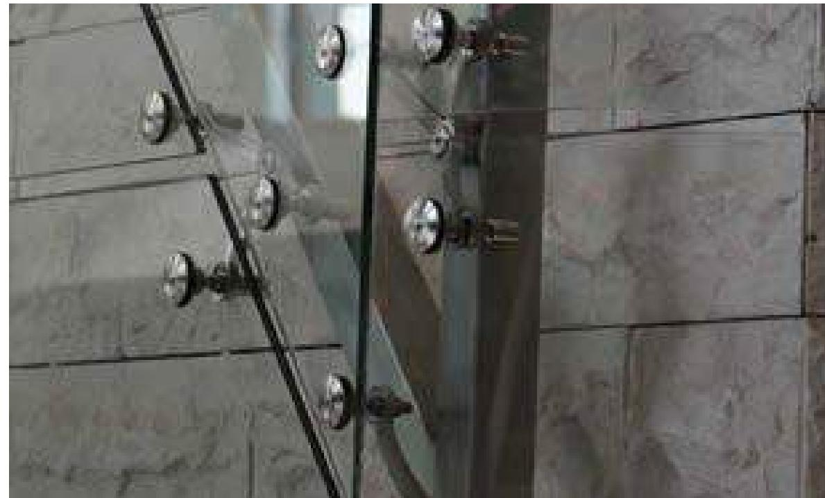
**Cam giydirmeye sistemlerimiz, camların çelik veya cam kiriş-kolon taşıyıcılarına paslanmaz bulonlar ve özel spider bağlantı aparatlarıyla monte edilmesiyle oluşturulmaktadır.**
