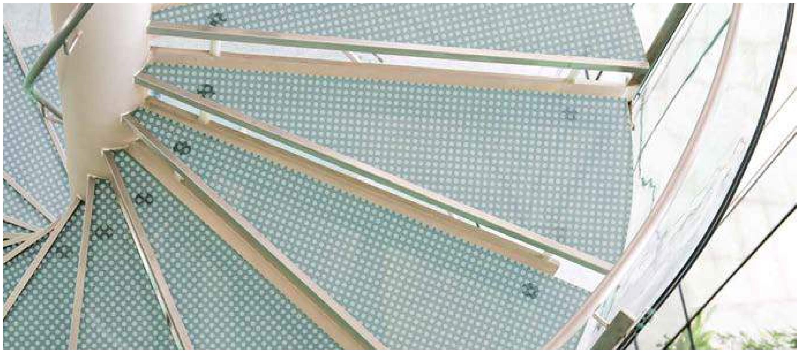
**Cam zeminler ve basamaklar; 2 kattan 5 kata kadar istenen kalınlıklardaki camın özel tekniklerle temperlenip lamine edilmesiyle üretilmektedir.**
